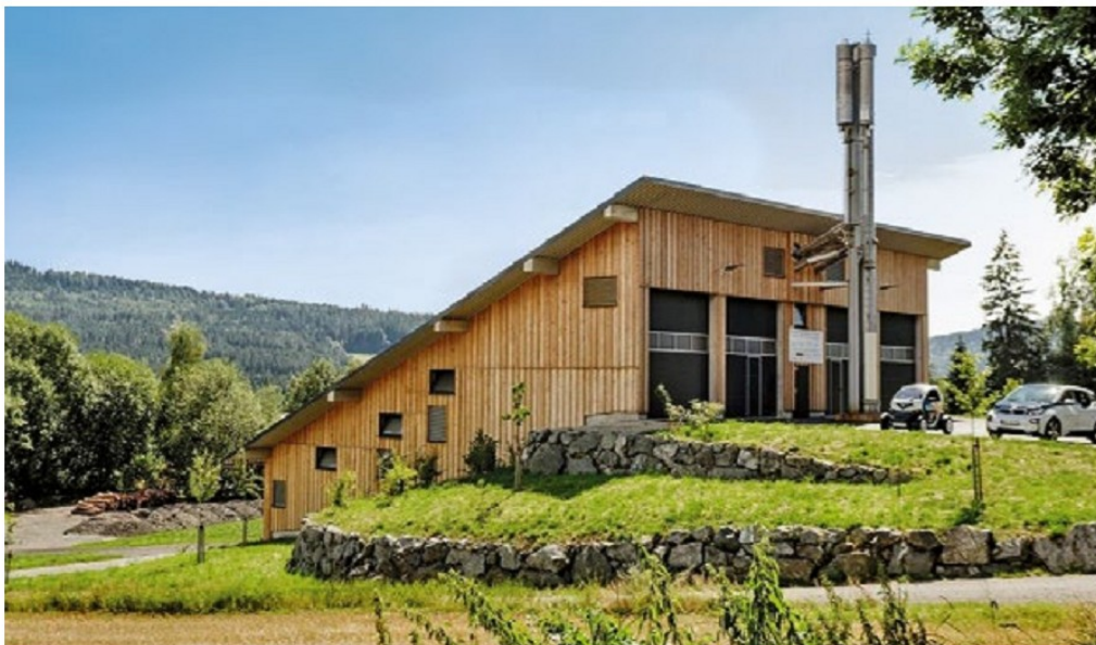
Die Heizzentrale am Ortseingang hat genügend Kapazität, um ganz Schönbrunn mit Wärme zu versorgen. Die Arbeiten für die Erweiterung und Nachverdichtung des Nahwärmenetzes haben schon begonnen. Dann wird es noch mehr Haushalten möglich sein, umweltfreundliche und regionale Wärme zu beziehen.
